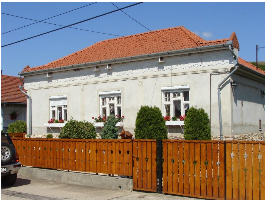
Eredeti nyílászárók és ornamentika
